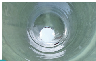
Canalisation après chemisage Photo d'illustration
