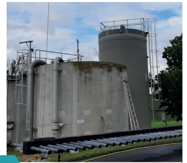
Des « poreux » remis à neuf et prêts à être replacés dans le bassin d'aération.
