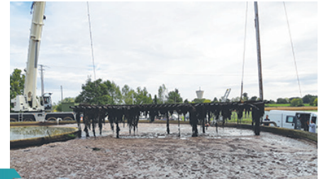
Sortie de la rampe de diffusion du bassin à l'aide d'une grue.
