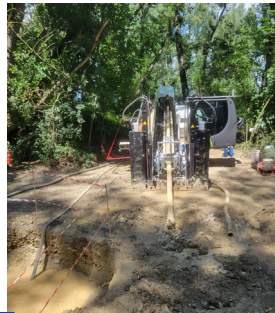
Forage dirigé en vue du passage de la canalisation
