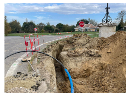
Passage de la canalisation sous la route départementale
