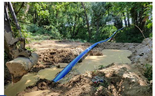
Passage de la canalisation sous la Garonne suite au forage dirigé
