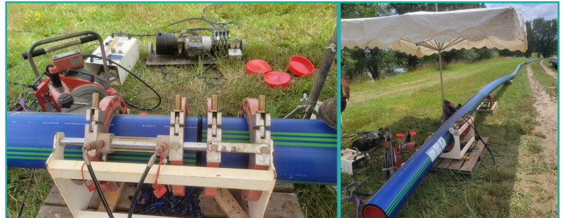
Electrosoudure de la canalisation en polyéthylène, afin de déployer les 178 mètres de réseau
